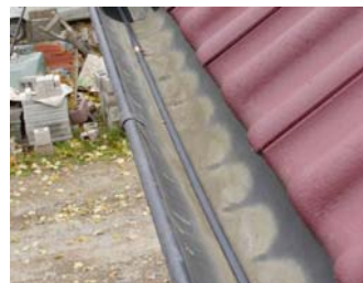
Instalace v okapovém žlabu
