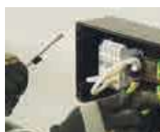
Montáž přípojovací krabice nVent RAYCHEM JBM
