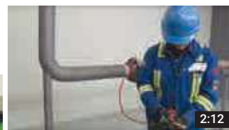
Montáž soupravy koncového těsnění nVent RAYCHEM E-100
