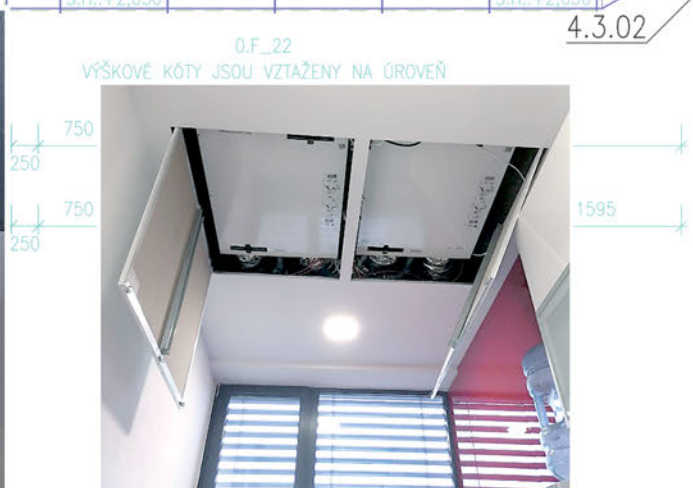
Použití dvou paralelních jednotek Brink SKY dovolilo navýšit vzduchový výkon a zachovat maximální výšku stropu.
