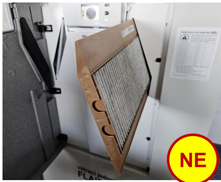
Neoriginální filtr má oproti originálnímu filtru BRINK více než 3x vyšší odpor.
