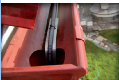
Ochrana okapů na řadě bytových domů
