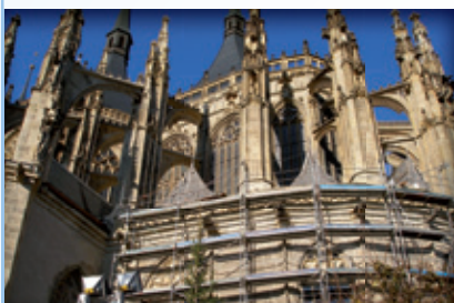
Ochrana okapových žlabů na historických budovách např. sv. Barbora Kutná Hora
