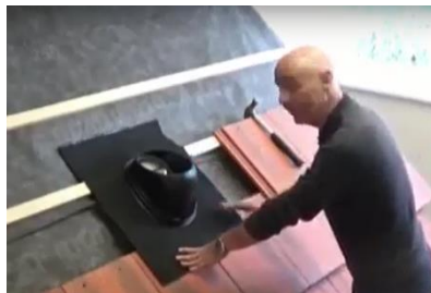
Osadte Univerzální střešní průchodku skrz střechu
