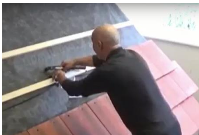
Otevřete střechu a připravte otvor ve fólii
