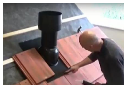
Vytvarujte střešní průchodku dle tvaru střešní krytiny a dle potřeby přilepte na spodní straně ke střeše těsnícím tmelem
