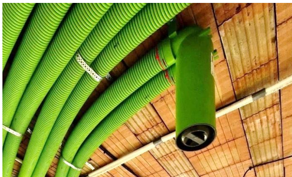
Součástí tvarovek AE jsou víčka proti znečištění během stavebních prací
