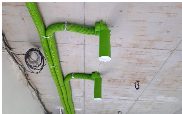
Snadné ohýbání potrubí AE a jeho zakončení tvarovkou
