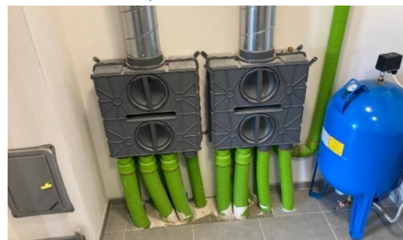
Osazení rozdělovacích boxů na stěnu
