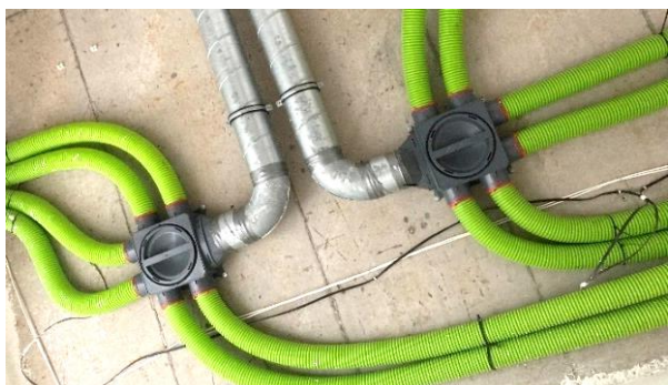
Instalace AE s nízkými rozvodnými DBoxy pod strop do podhledu s minimálním snížením stropu
