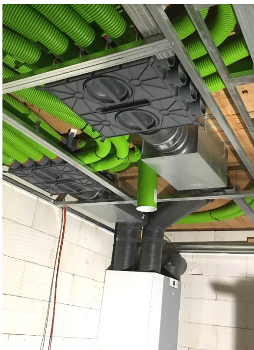
Pevný plochý tlumič skrytý v podhledu nesnižuje výšku podhledu. Tlumič má čistitelný vnitřní povrch.
