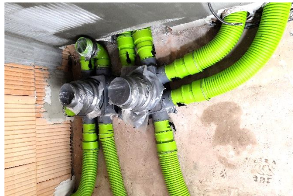
Rozdělovací D-Boxy s regulátory průtoku
