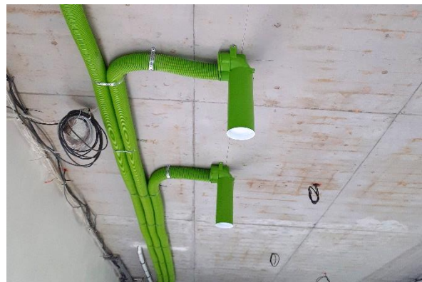
Snadné ohýbání potrubí AE a jeho zakončení tvarovkou
