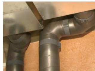
Potrubí se propojuje pomocí spojek se samosvěrnou sponou, která umožňuje i snadnou demontáž a revizi potrubí
