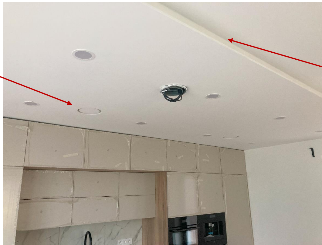
Lineární difuzory LINE v hraně níženého SDK pro přívod vzduchu
