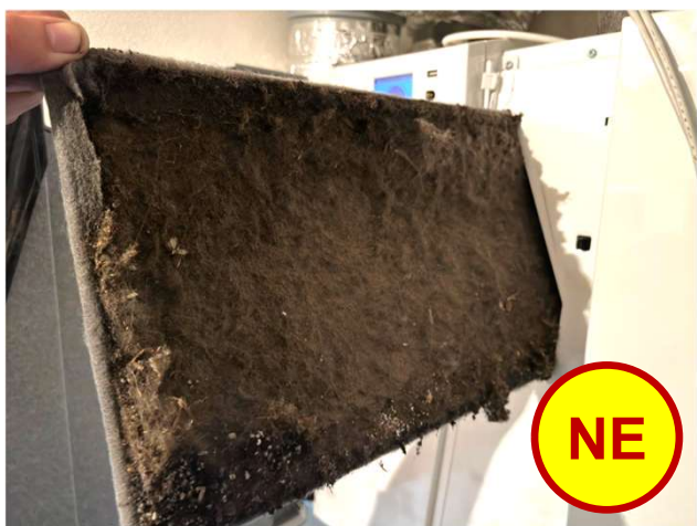
Příklad zanedbaného a znečištěného filtru, který vedl k nárůstu odporu až 280Pa !!
